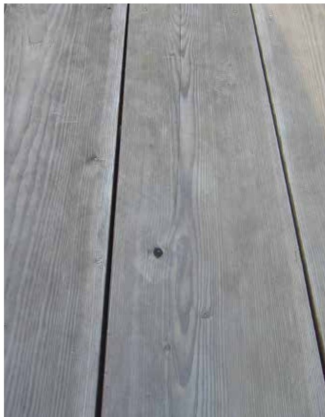
Douglas terrasse der har ligget en periode på 2-3 år alt efter vejrforhold
