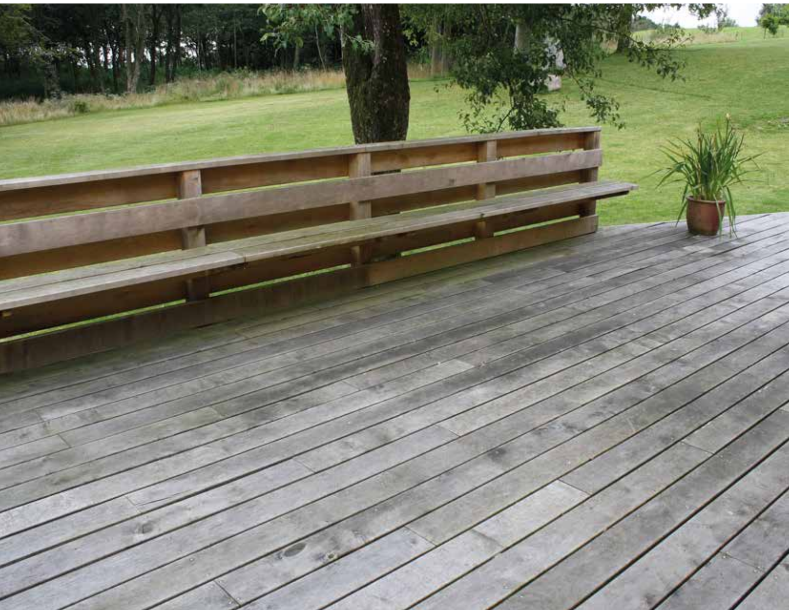
Eg | Terrasse | Stubbekøbing Havn | Patineret uden overfladebehandling
