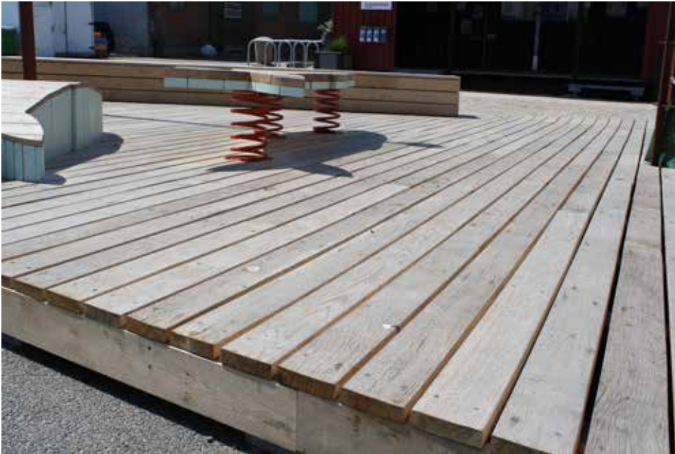
Eg | Terrasse | Stubbekøbing Havn | Patineret uden overfladebehandling
