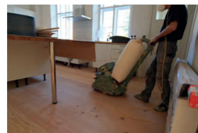
Slibning før overfladebehandling
