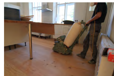
Slibning før overfladebehandling
